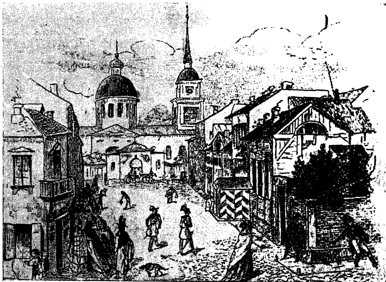
Вид Коломны в пушкинские времена
